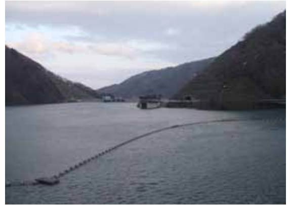
試験湛水状況 (H22.4.30)
