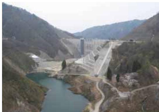
上流より長井ダムを望む
